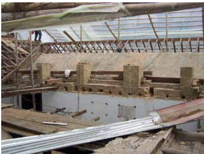
Fig.2. Obra de restauración. Estado de la obra dos meses antes de la inauguración
